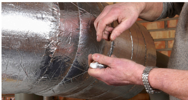
Spirallindning med förzinkad ståltråd som knopas minst en gång per enhet.
